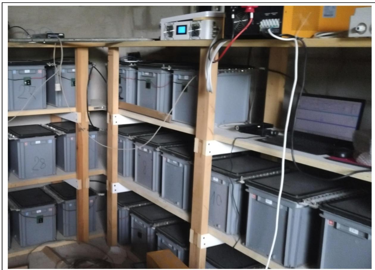
**Singola Cella Supercondensatore – Peso 35 Kg - 120 Wattora di accumulo – Tensione 1,8 Volt – Capacità 360.000 Farad**
